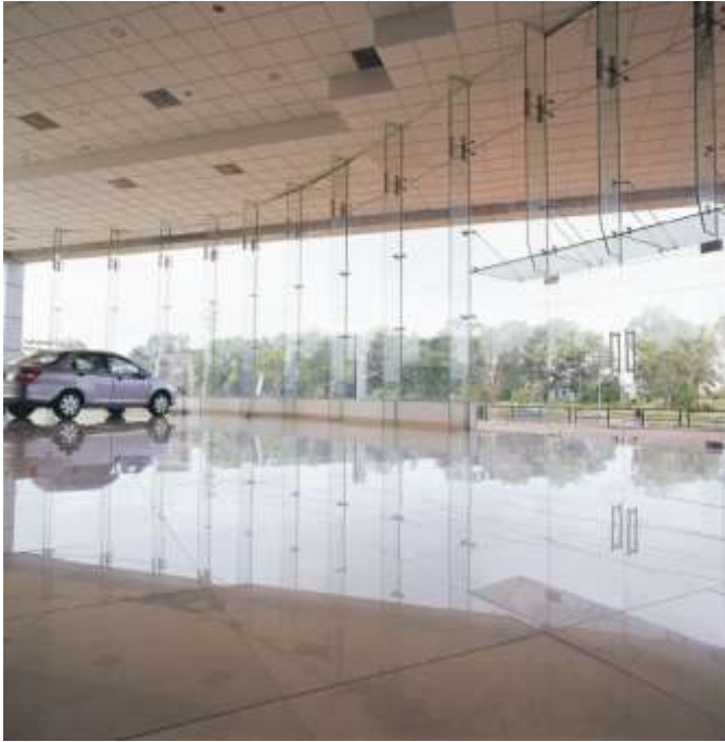
Рис. 8. Спайдерное крепление фасада, ребер жесткости и козырька
