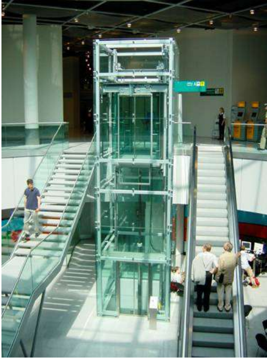
Рис. 4. Остекление шахты лифта
