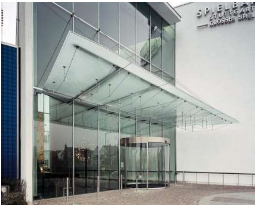
Рис. 7. Крепление стекляннх козырьков
