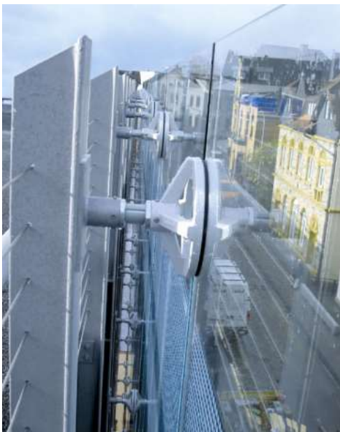
Рис. 9. Установка спайдерного крепления на стыке стекол в вырезах.
