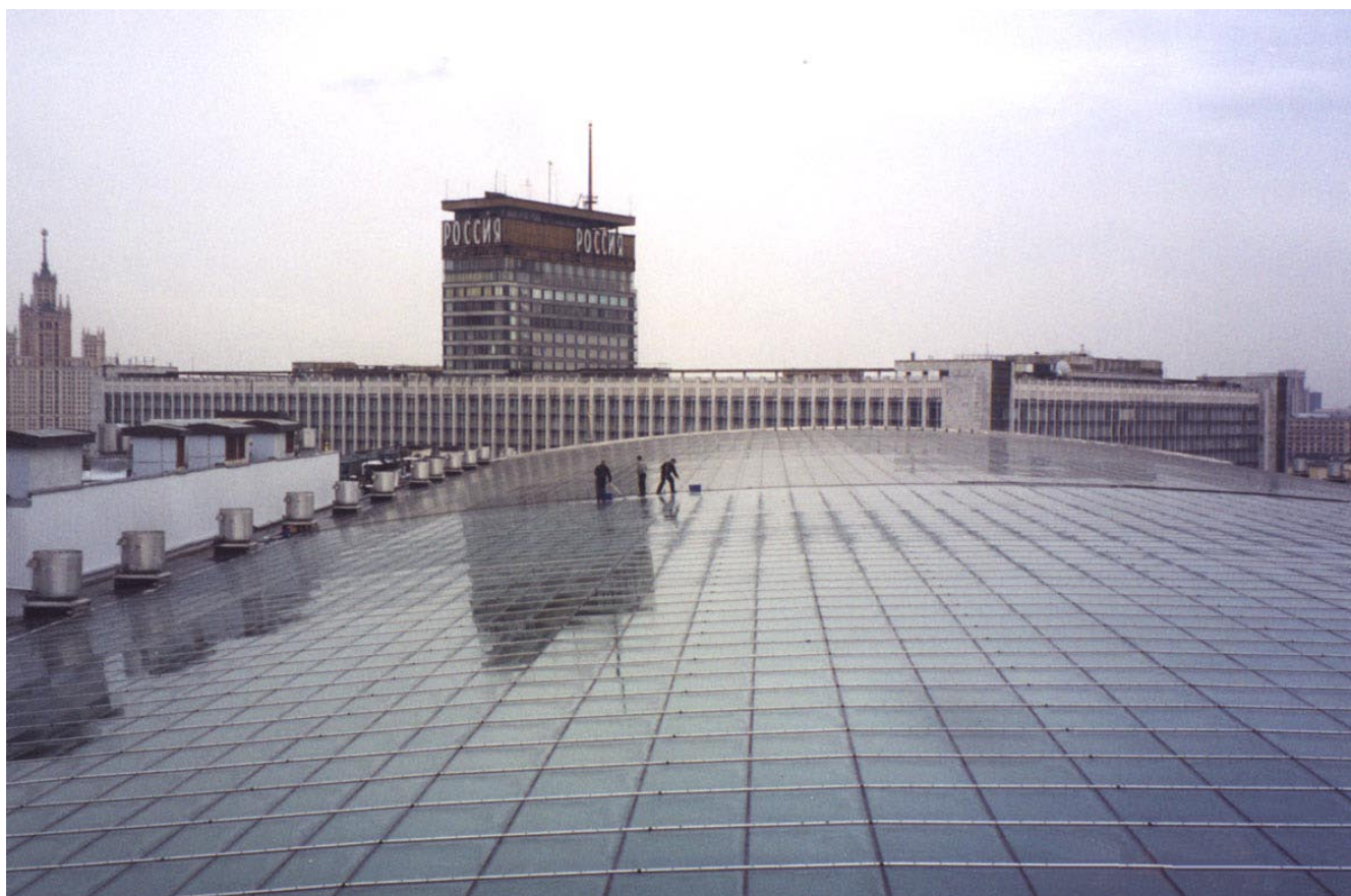
Рис. 4. Стеклянная крыша на Гостином дворе из электрообогреваемых стеклопакетов
