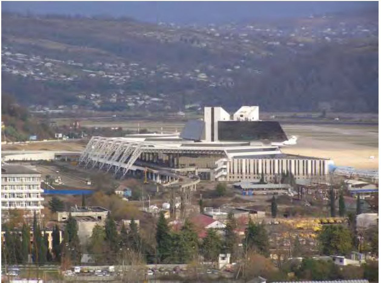
Рисунок 2. Новое здание аэропорта Сочи (на фото еще строящееся, в настоящее время уже законченное) содержит солнечные панели в составе остекления
